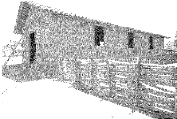
Fotografía 5: Estado de avance de los trabajos del proyecto: "La antigua iglesia de Progreso"
