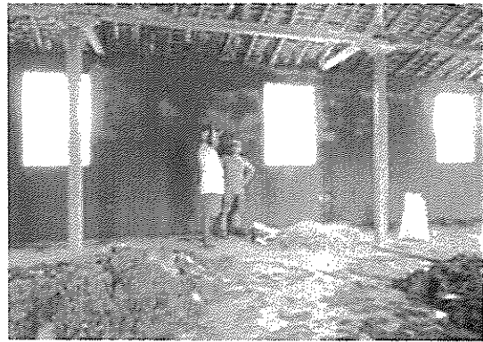
Fotografía 6: Estado de avance de los trabajos del proyecto: "La antigua iglesia de Progreso"
