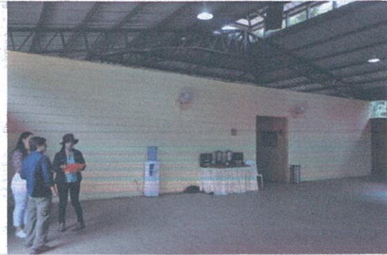
Fotografía nro. 6: Inspección IBI-07-11-50-000-000109 – Bodega SADCO, cantón Portovelo.
