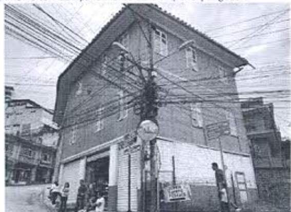
Fotografía 5: Registro fotográfico de inmueble inspeccionado.
