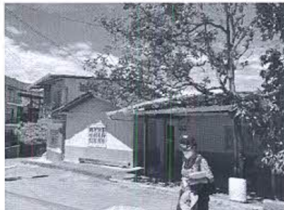
Fotografía 6: Registro fotográfico de inmueble inspeccionado.
