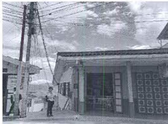
Fotografía 4: Registro fotográfico de inmueble inspeccionado.
