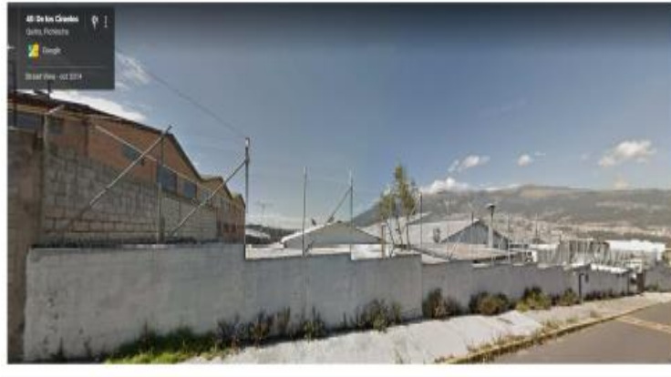
Imagen 2. Fachada principal actual
