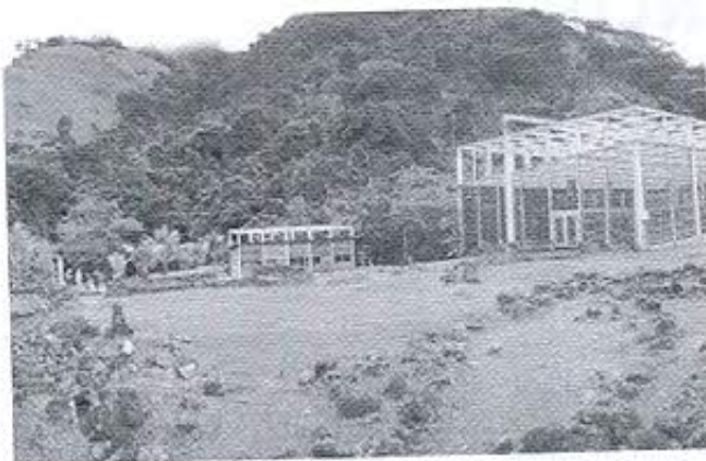
Foto 1: Inspección técnica del sitio arqueológico Santa Ana – La Florida.
