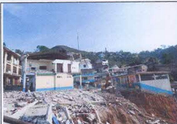
Fotografía nro. 3: Trabajos de liberación de escombros en Escuela La Inmaculada Fuente: INPC R7
