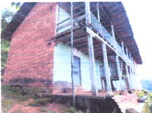
Fotografía 4: Detalle de sistema constructivo de edificación
