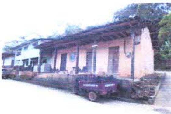
Fotografía 2: Tramo Mz 12. Calle 21 de mayo
