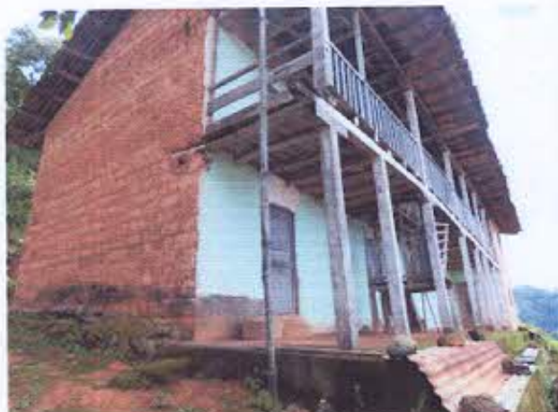
Fotografía 4: Detalle de sistema constructivo de edificación
