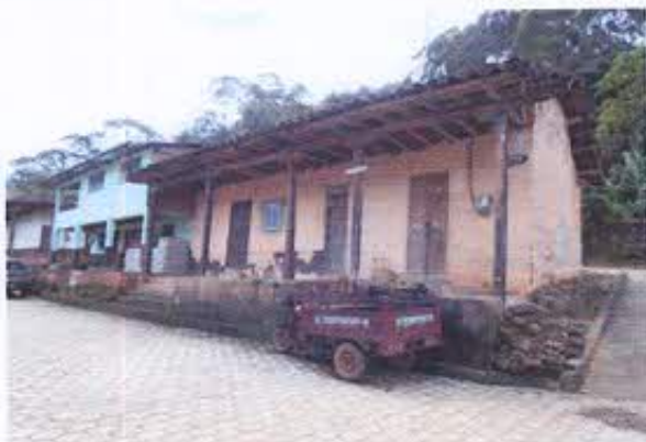
Fotografía 2: Tramo Mz 12. Calle 21 de mayo
