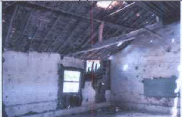
Foto 6: Detalle de estructura de cubierta
