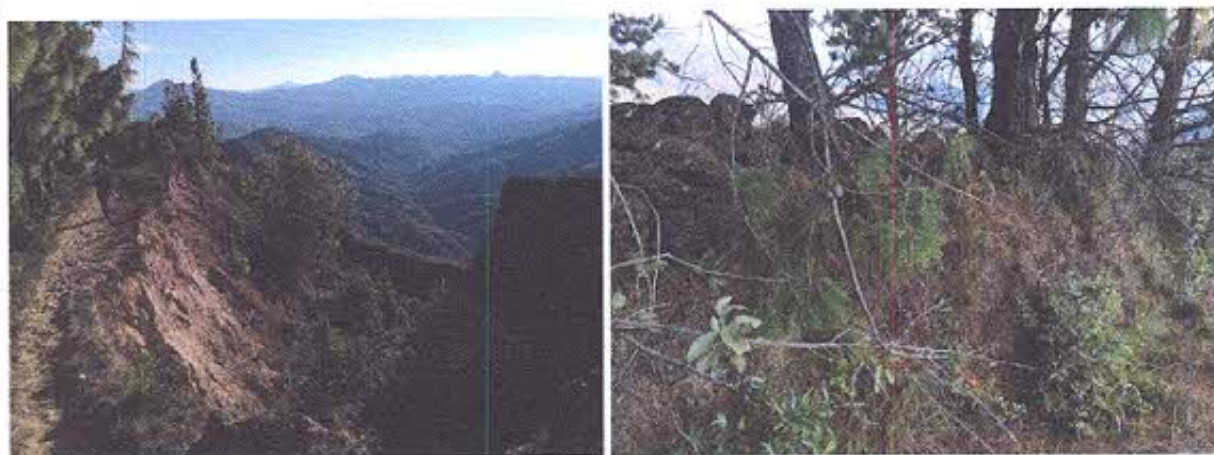
Foto 4 y 5:- a lado izquierdo se puede observar el deslizamiento de suelo que ha destruido el camino. A lado derecho se observa los muros que aún se han conservado.
