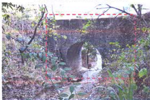
FOTOGRAFIA NRO. 3. IBI-07-11-50-000-000117 – Puente- Portovelo
