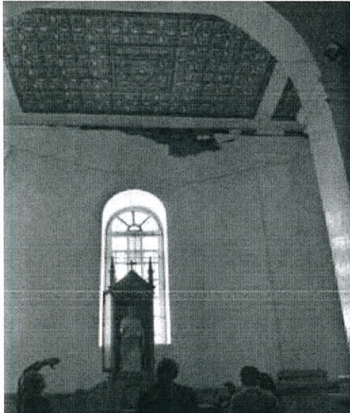
Inspección Regional 5.- Templo de la Magdalena (cantón Chimbo); deterioro en la parte superior de los muros en los que se apoyan elementos muebles (retablos, casetones) y sus consiguientes imágenes asociadas.
