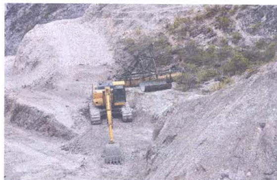
Fotografía2: Maquinaria en el sector de la Quebrada El Saldo
