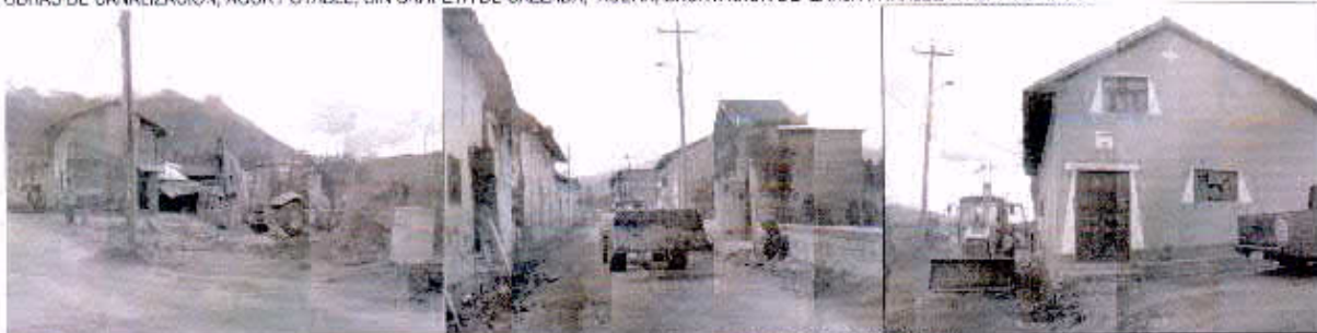
DERROCAMIENTO, INTERVENCION QUE INCIDEN EN EL ESTADO DE CONSERVACION, DETERIORO DE LOS INMUEBLES
