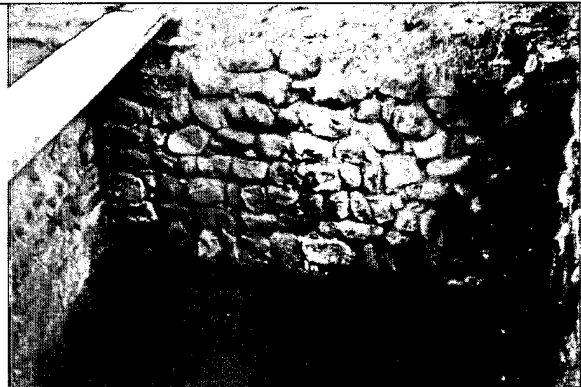
Parte de estructura al interior del trapiche
