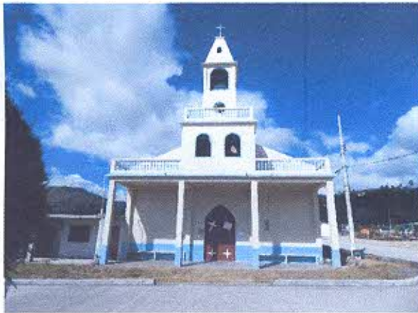
FOTOGRAFIA NRO. 3. Reconocimiento y registro de las tipologías arquitectónicas del barrio El Tablón
