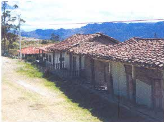
FOTOGRAFIA NRO. 3. Tramo arquitectónico Tablón Viejo
