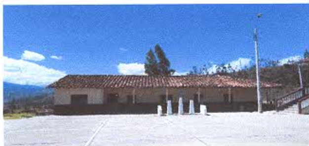
FOTOGRAFIA N°1. Escuela de Cachipamba. Edificación de un piso con portal, muros de adobe cubierta inclinada de teja.
