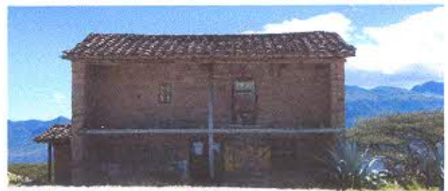
FOTOGRAFIA N°2. Edificación con portal y soportal de madera, muros de adobe y cubierta inclinada de teja
