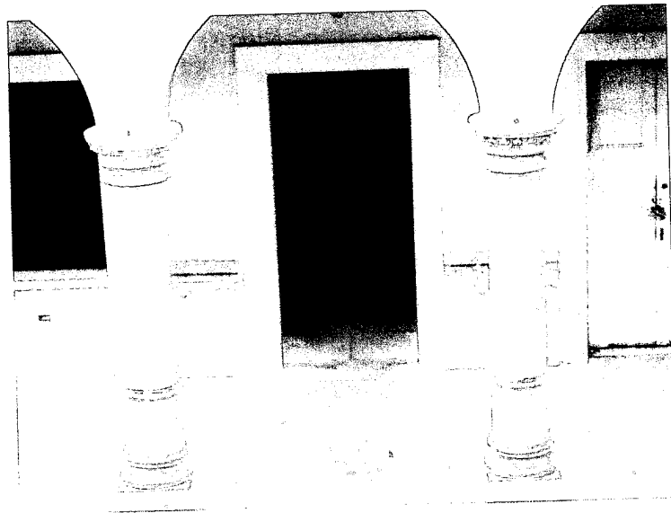
Es el estado de conservación de la obra el que plantea que técnica de integración de lagunas amerita ejecutar
