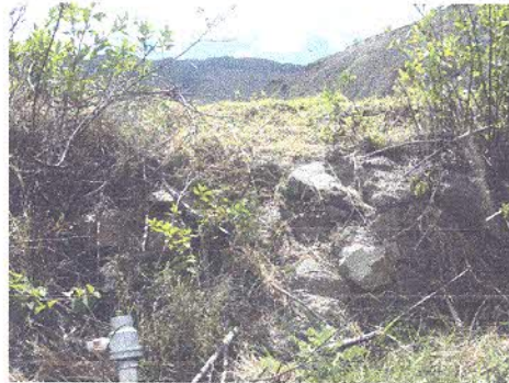
Muros hacia el exterior del canal
