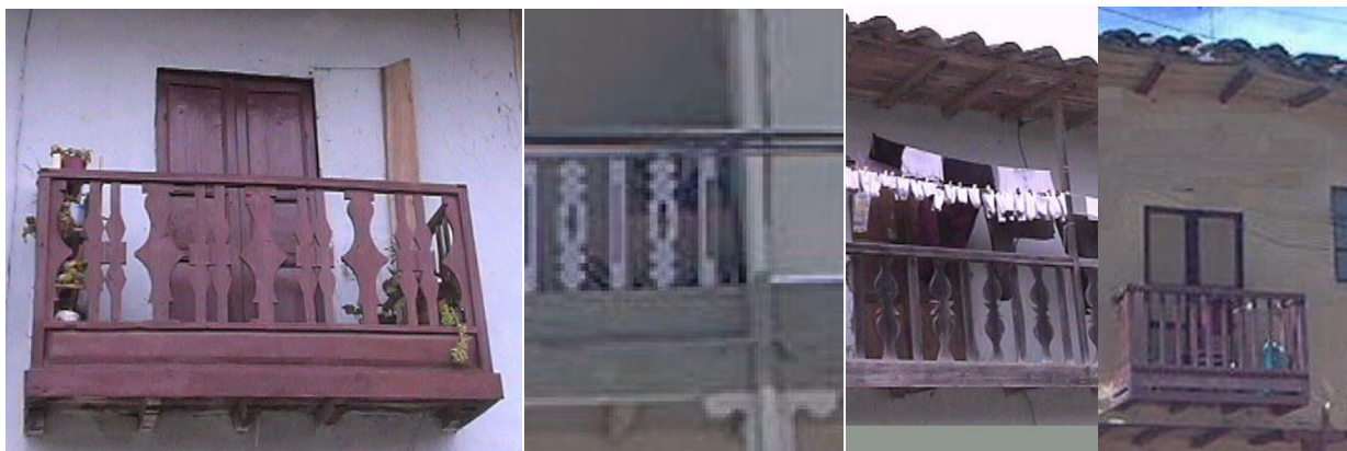
41.- Fotografías N° 26 - 29 Detalles constructivos: la decoración se concentra especialmente en los balcones y canchillos.
