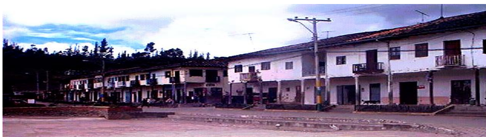
48.-Fotografías N° 38.- Tramos Urbanos
