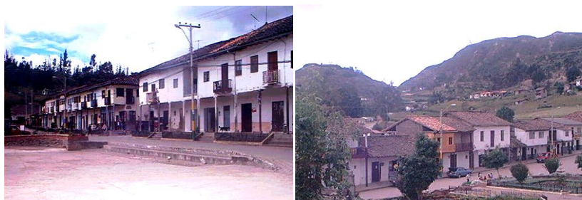
51.- Fotografías N° 42 – 43.- Tramos del área central.
