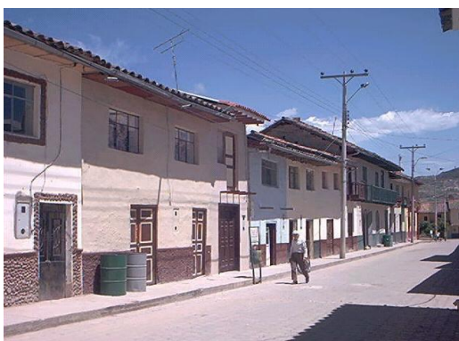
49.-Fotografías N° 39.- Tramos Urbanos
