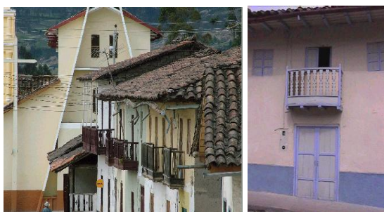
54.- Fotografías N° 50-51.- Caracteriza y define el tramo la presencia de balcones “colgados” desde el canecillo de la cubierta y el color.
