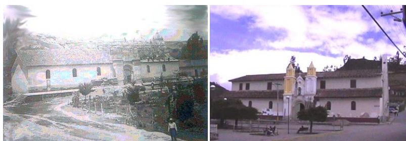
50.-Fotografías N° 40 - 41.- Iglesia antigua y actual.
