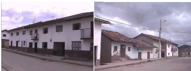
55.- Fotografías N° 52-53.- Conjunto de viviendas adosadas.
