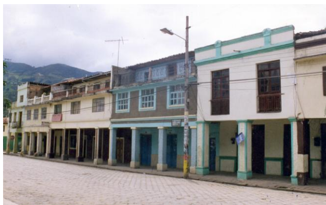
12.- Fotografía N° 9.- Tramo urbano: Plaza
