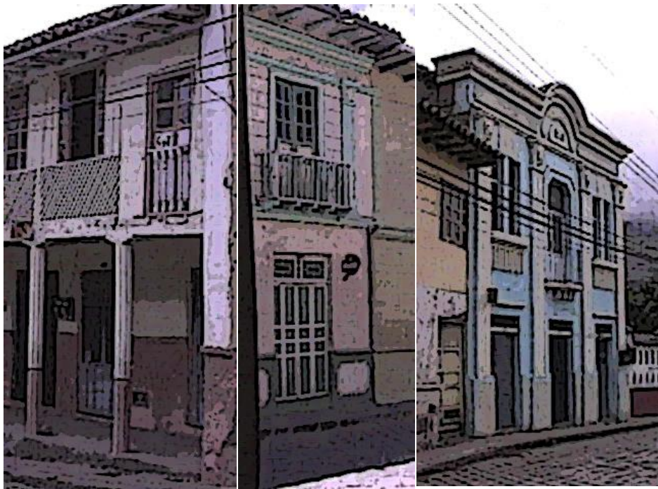
22.- Fotografía N° 16.- Detalles constructivos de fachadas
